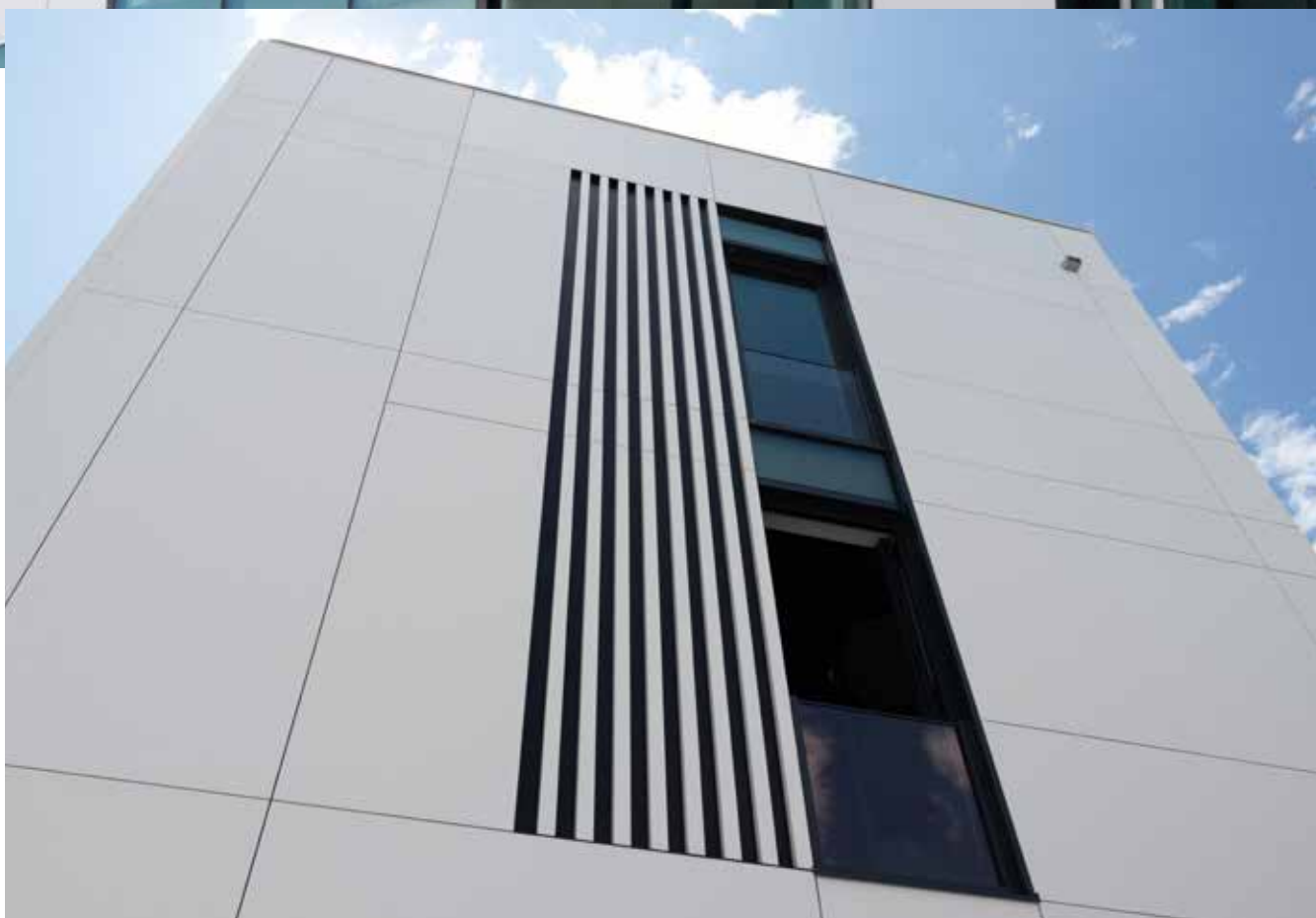
Poslovna stavba podjetja TAPRO, d.o.o.
